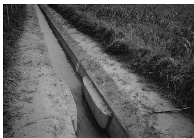
图 12 U形渠道直壁式量水槽
