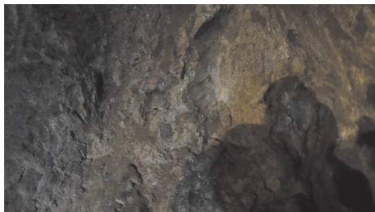
图10 开挖20 m处掌子面 Fig. 10 Excavation 20 m of the tunnel
