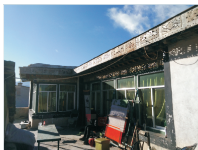
图 1 测试建筑的实景图
