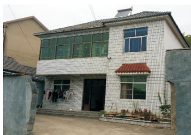
图 1 某乡村建筑实景图
