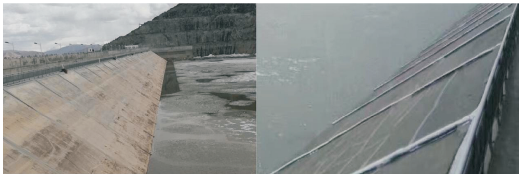
图1 纳子峡纤维混凝土面板堆石坝
