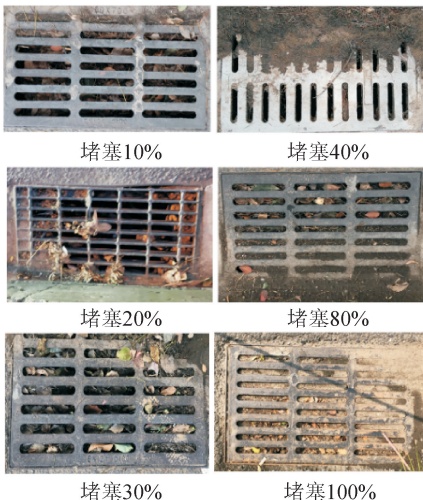
图7 雨水篦子堵塞 Fig. 7 Rainwater grate clog
