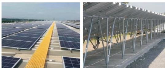
图 1 冷弯薄壁型钢太阳能光伏支架
