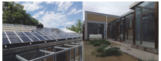
图4 装配式草砖结构农宅实景图
